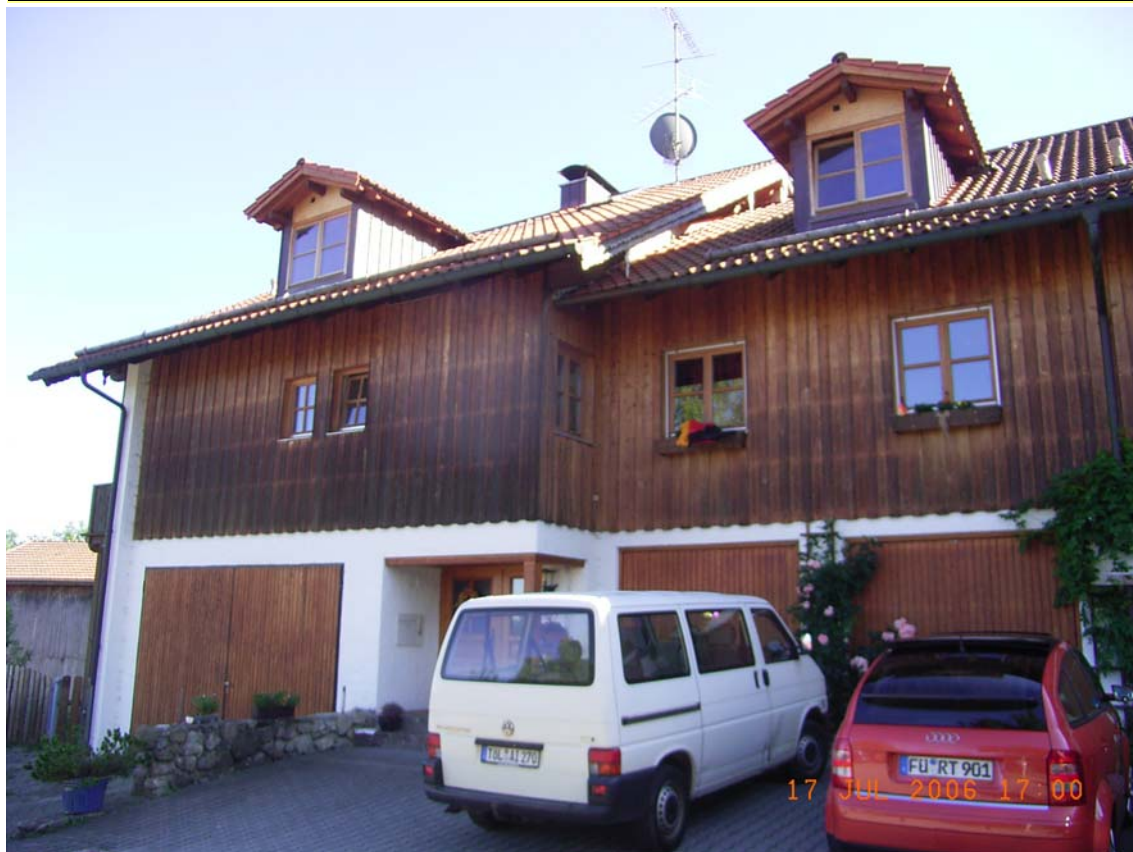
Foto 5: Blick auf den Messpunkt im 1. OG
