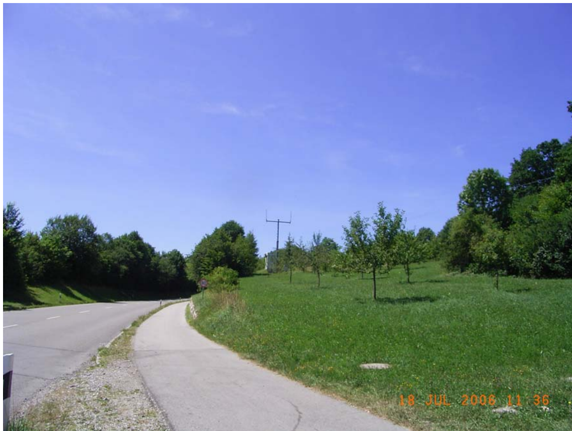
Foto 2: Blick auf die Sendeanlage von T-Mobile neben dem Bauhof
