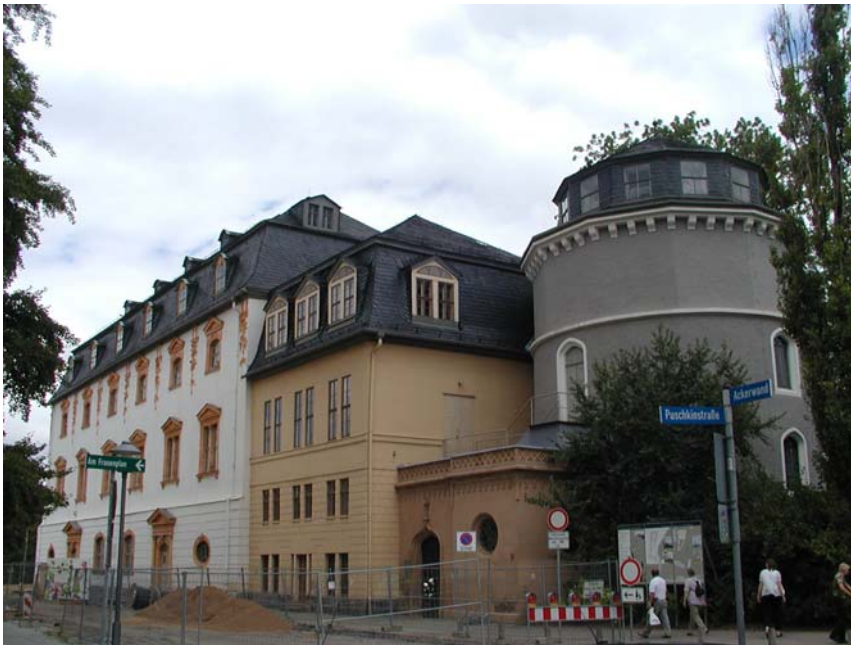
Abb 1: Das Gebäude mit dem Rokokosaal, der sich im hintern Teil mehrere Etagen erstreckt.
